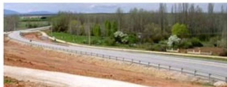
Las obras de la nueva variante, de casi cinco kilómetros, se han ejecutado durante casi dos años. / El Adelantado
